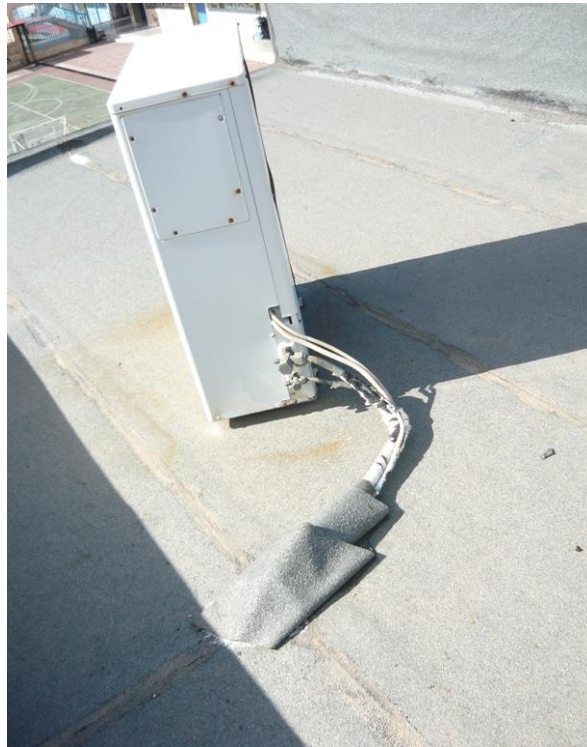
Εικόνα 14. Μόνωση σωληνώσεων εξωτερικής μονάδας κλιματισμού
