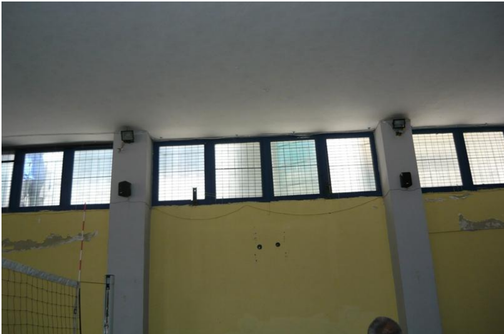
Εικόνα 11. Υπάρχοντες φεγγίτες ΑΠΧ. Οι μηχανισμοί ανάκλισης θα τοποθετηθούν στα νέα κουφώματα.
